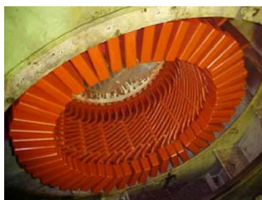
Figura 6. Estator do Gerador nº3 após o rebobinamento.
