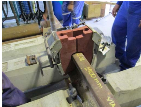
Figura 4. Fixação dos moldes cerâmicos através de suportes e grampos metálicos.
