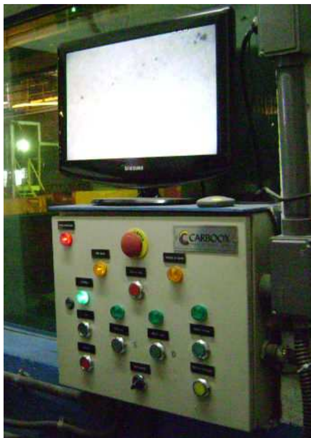
Figura 9 – Monitor do sistema de adição de areia
