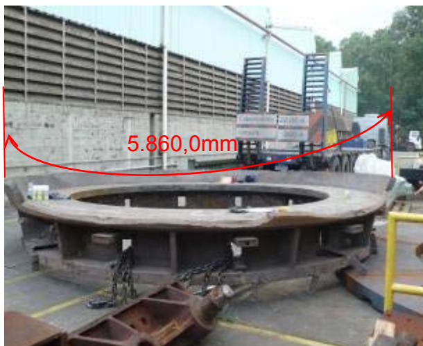
Figura 4. Vista da região de trinca.
