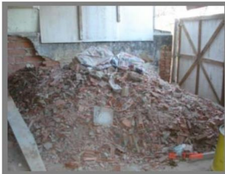
Figura 3: Rejeitos de Blocos Cerâmicos e Argamassas
