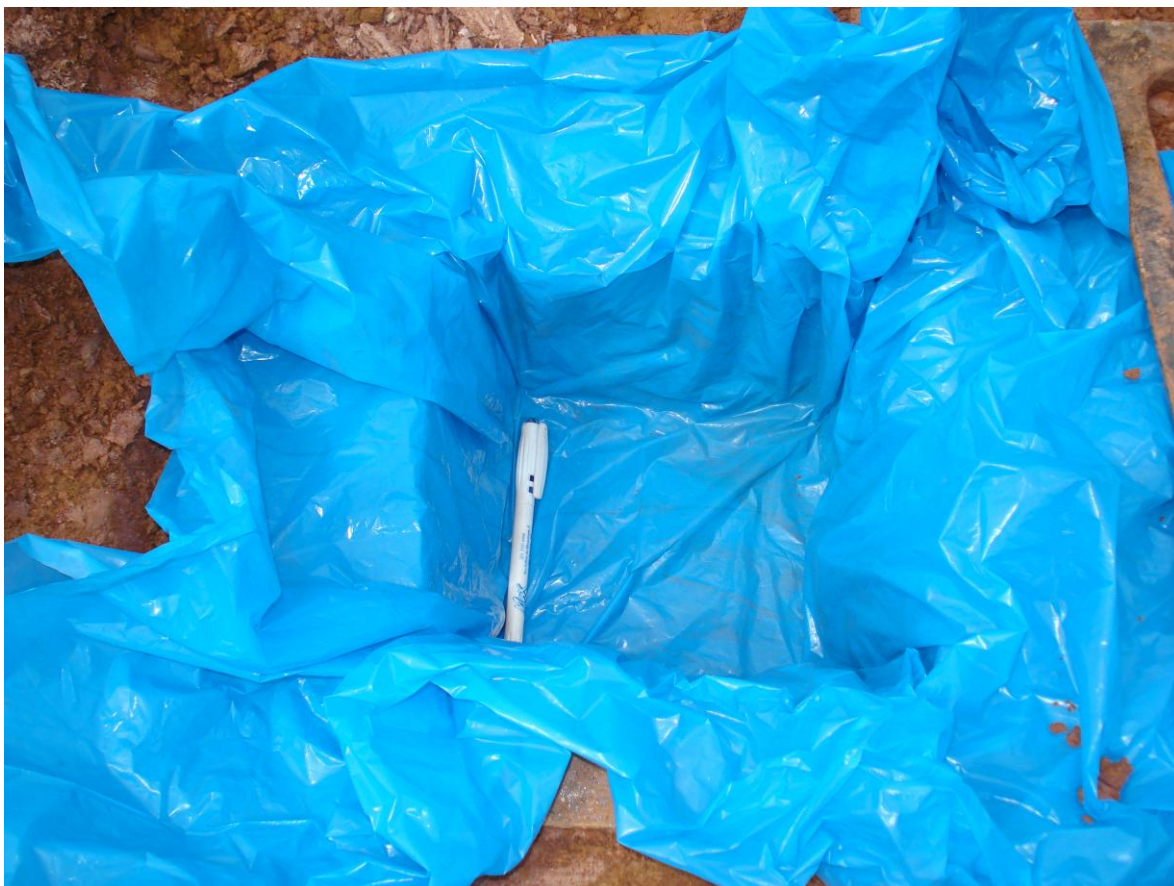
Figura 33 – Revestindo o poço
