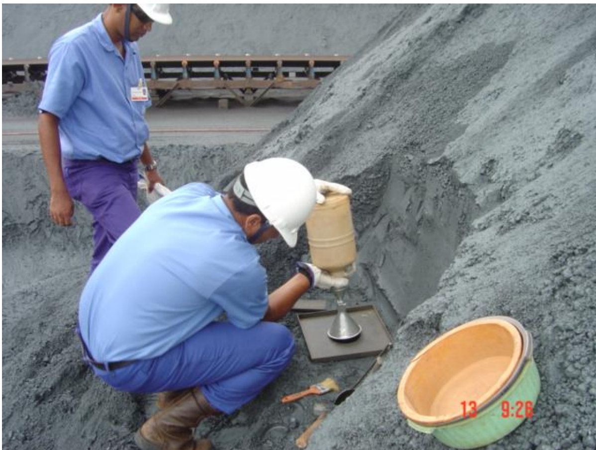
Figura 27 – Colocando a areia
