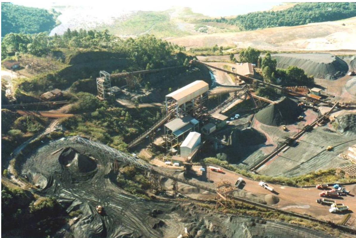
Figura 2 – Usina de beneficiamento
