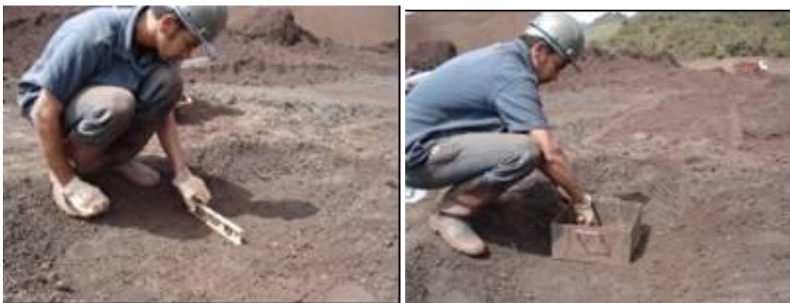
Figura 28 – Nivelando o gabarito
