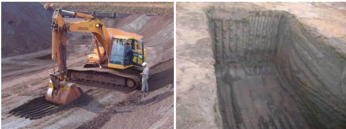
Figura 41 – Cavando a vala
