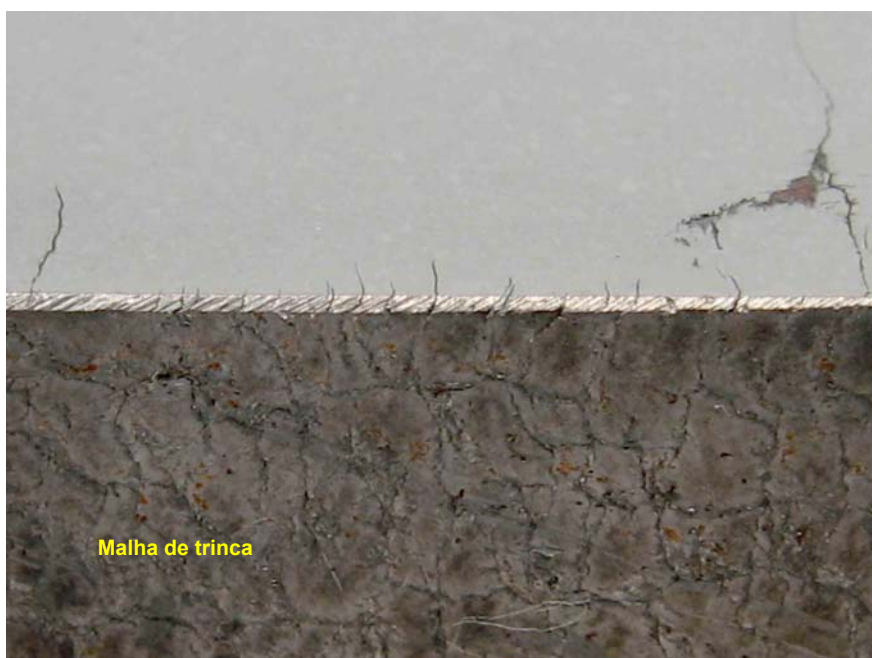
Figura 6: Seção imediatamente abaixo da fratura, mostrando a malha de trincas, com profundidade.
