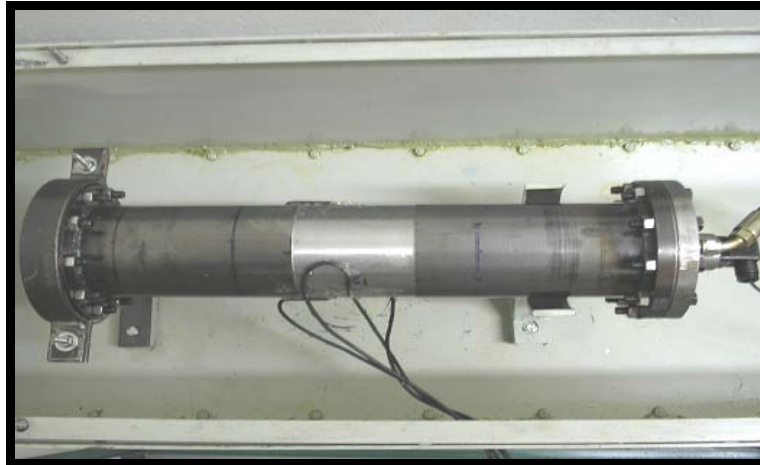
Figura 6 – Tubo de aço instrumentado e alojado na caixa de proteção
