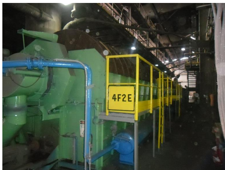
Figura 5. Painel de identificação dos filtros.
