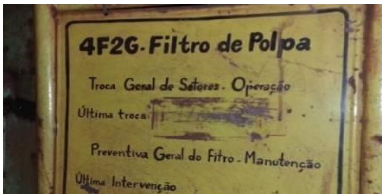
Figura 4. Painel de identificação dos filtros.
