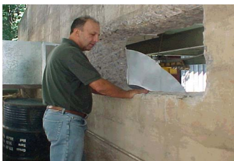
Figura 4: saída de ar quente dos compressores
