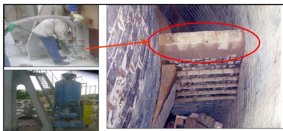
Figura 12. Projeção de massa – Recomposição do pilar
