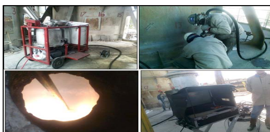
Figura 13. Solda cerâmica e Endoscopia – Reparo nos Arcos e Parede Falsa
