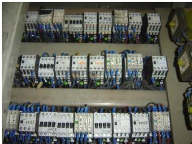
Figura 10. Exemplo de aglomeração em um antigo painel de relés de ETE-CC 2/3.
