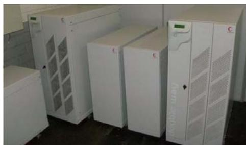
Figura 6. Nobreaks instalados na sala de controle.
