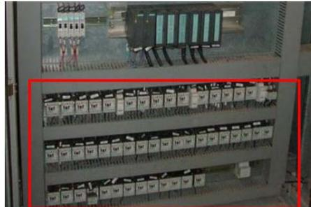
Figura 5. Painel de remota com contadores em destaque.
