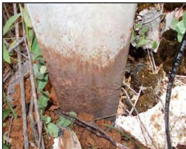
**Figura 3** – Ocorrência de corrosão por aeração diferencial observado em um montante de uma das torres inspecionadas em dezembro de 2012.
