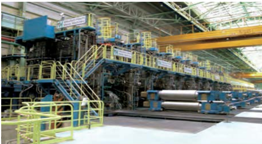
Figura 2. Vista geral de um sistema Linha de Tiras a Quente (LTQ), mostrando as cadeiras de Laminação e cilindros de trabalho sobressalentes.
