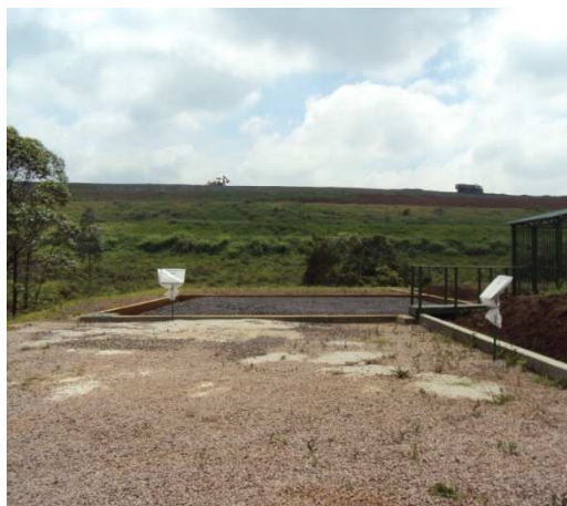
Figura 4. Módulo de rejeitos: teste de cobertura, Criciúma/SC.
