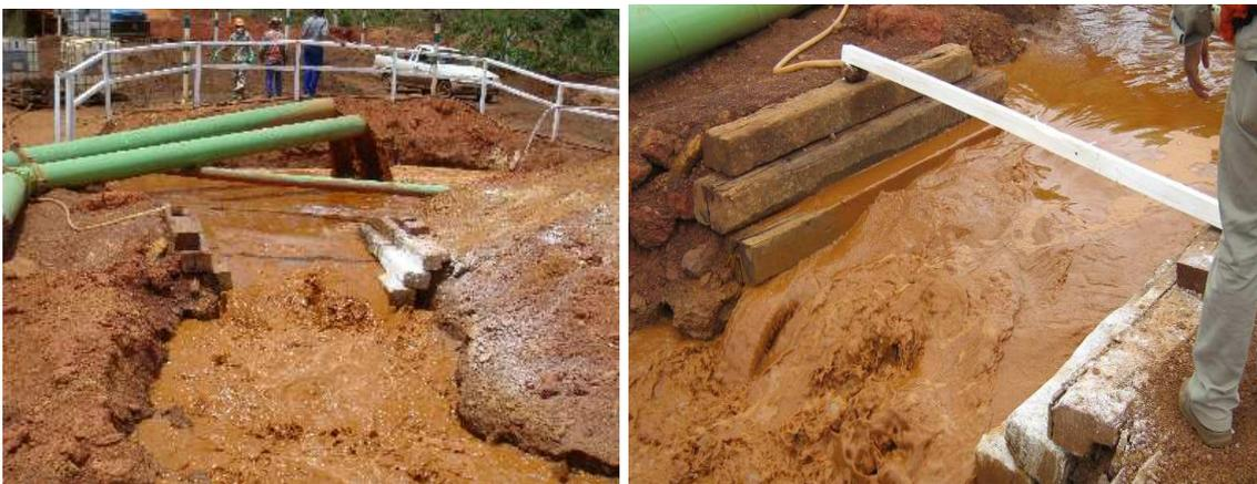
**Figura 6.** Extravasor do pré-sump e adição do DW 15 pela flauta.
