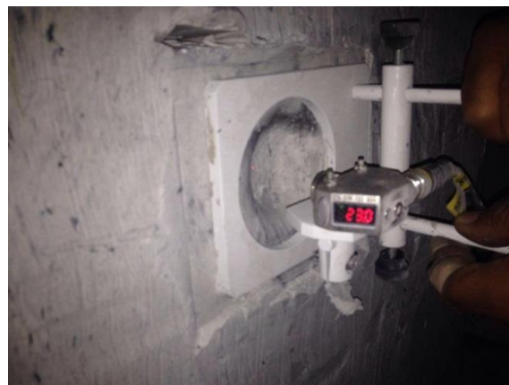
Figura 3. Profundidade de indentação na plastilina medida com o paquímetro com sensor laser.
