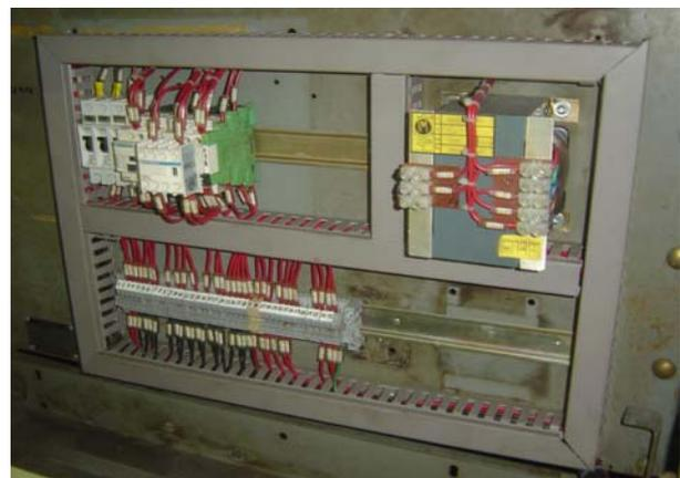
**Figura 5** – Painel após reforma - interno
