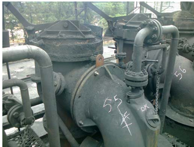
Figura 2. Isolamento do forno com “flange cego”.
