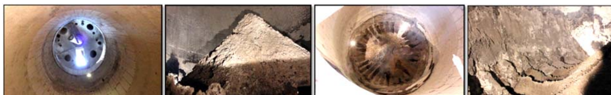
Figura 28. Aspecto interno do Alto Forno 03 após todos os procedimentos referentes ao Blowdown.
