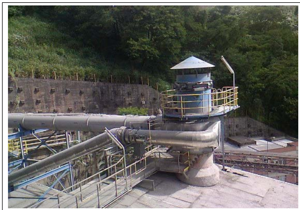
Figura 4: Construção finalizada do dispositivo de mistura de gases
