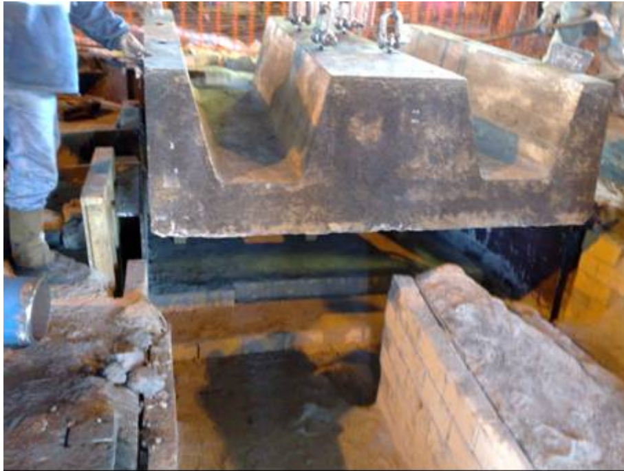
Figura 8. Instalação do bloco de entroncamento. (2)
