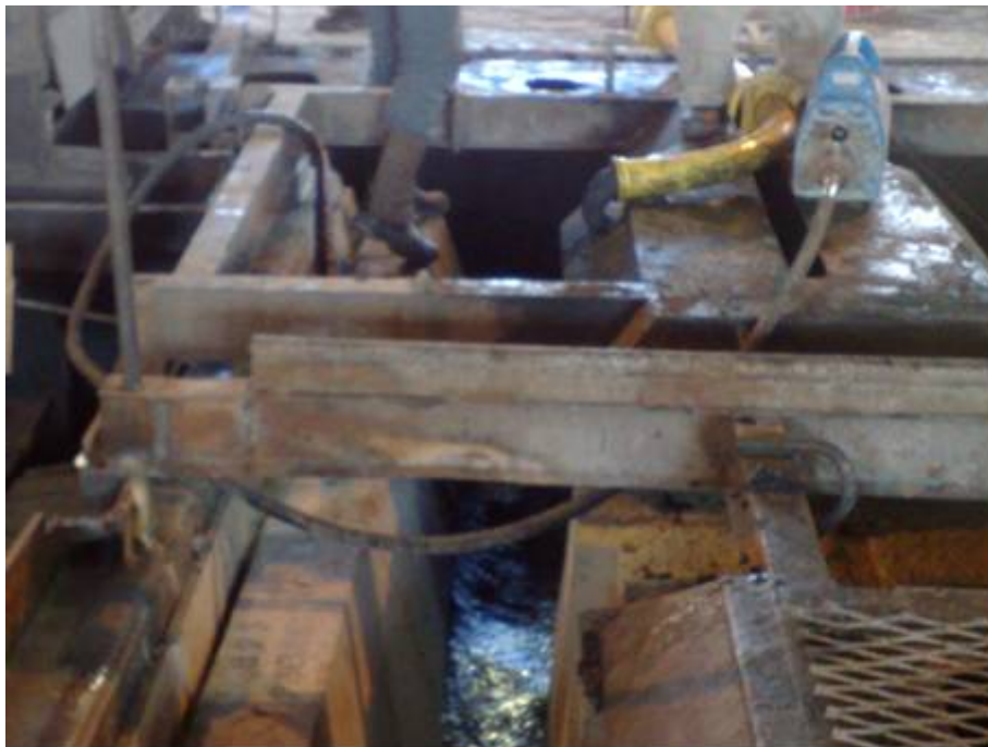
Figura 5. concretagem do canal principal. (2)
