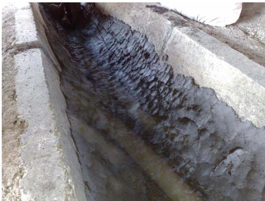
Figura 10. Instalação da massa de socar. (2)
