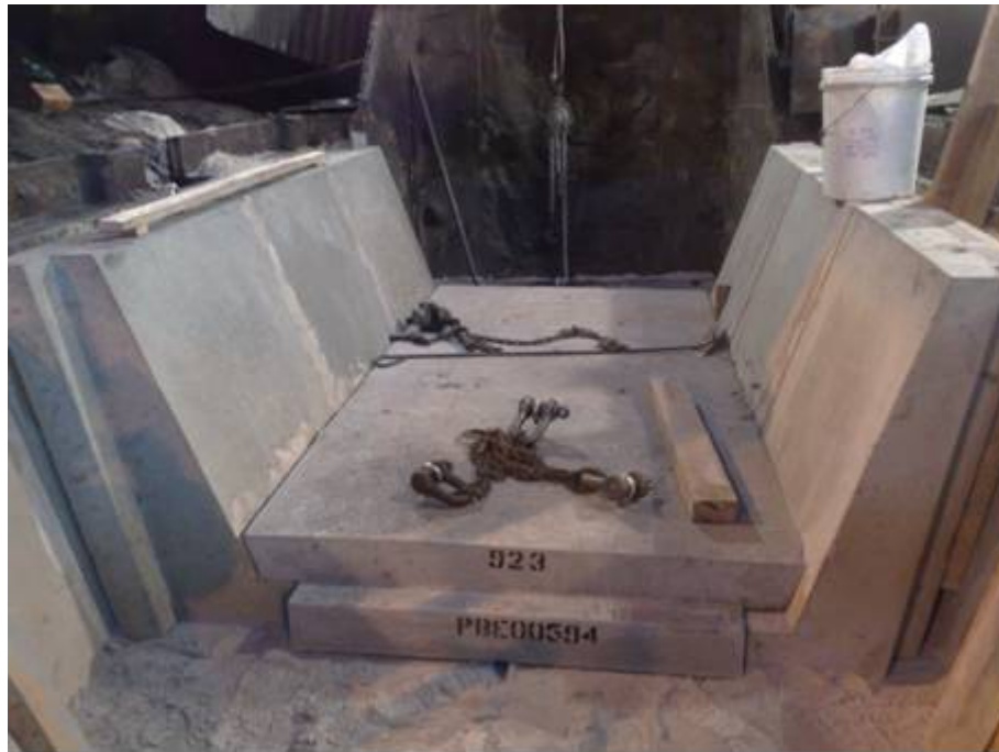
Figura 2. Instalação dos primeiros blocos pré-moldados. (2)
