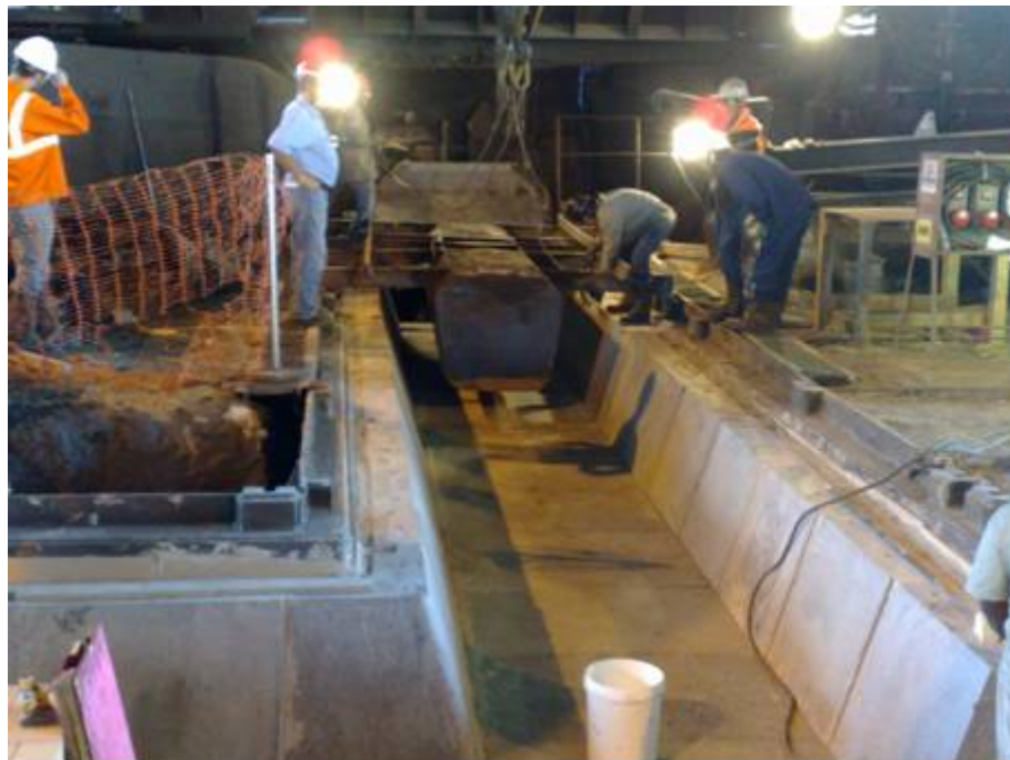
Figura 3. instalação da primeira forma metálica. (2)
