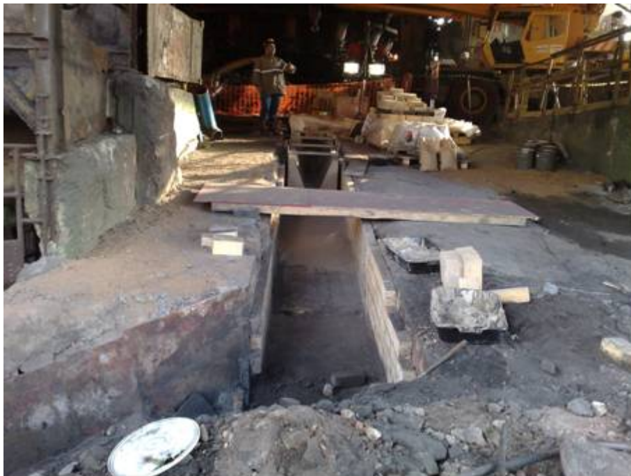
Figura 9. Instalação do bloco reto. (2)
