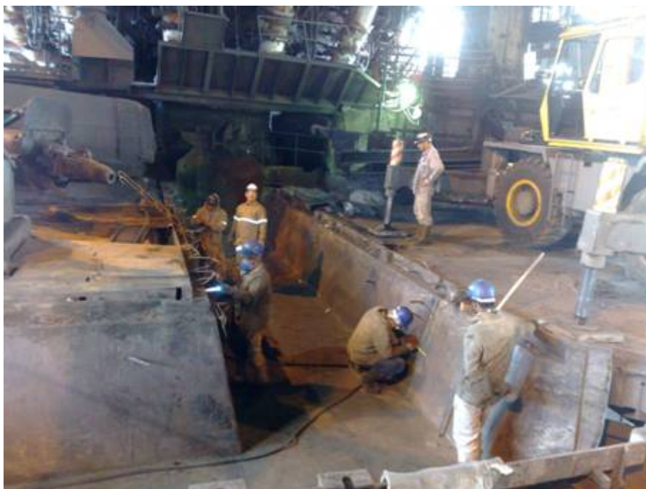
Figura 1. Atividades de caldeiraria na carcaça metálica. (2)
