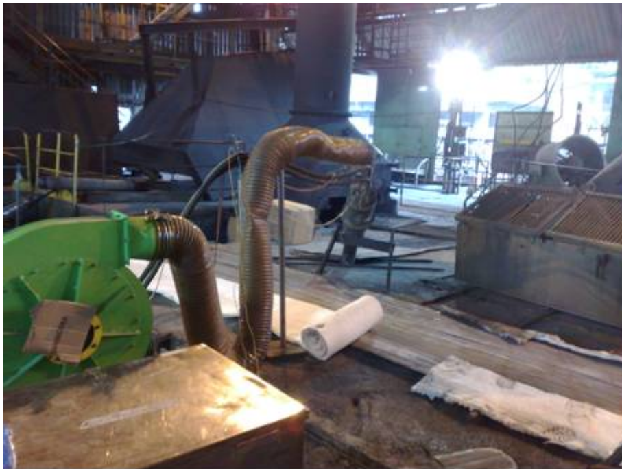
Figura 6. Equipamentos para a secagem e aquecimento do canal principal. (2)
