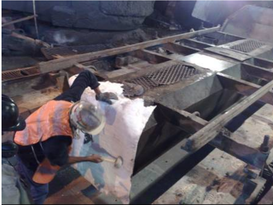
Figura 4. Colocação de fibra cerâmica entre as formas. (2)
