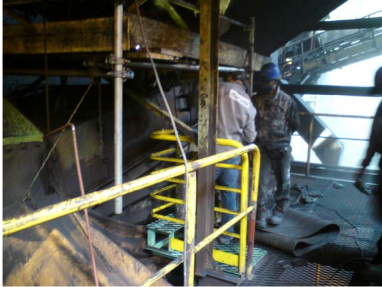
Figura 1. Instalação da plataforma para facilitar o acesso ao analisador de umidade.
