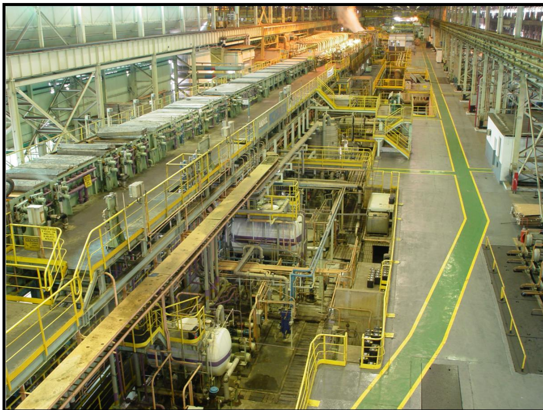
Figura 2: Vista geral da linha.
