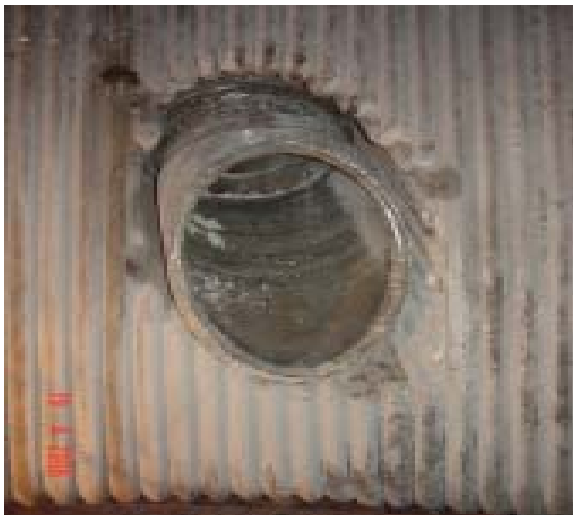
Figura 3. Chute novo, extremidade reformada, utilizando aço AISI 310.
