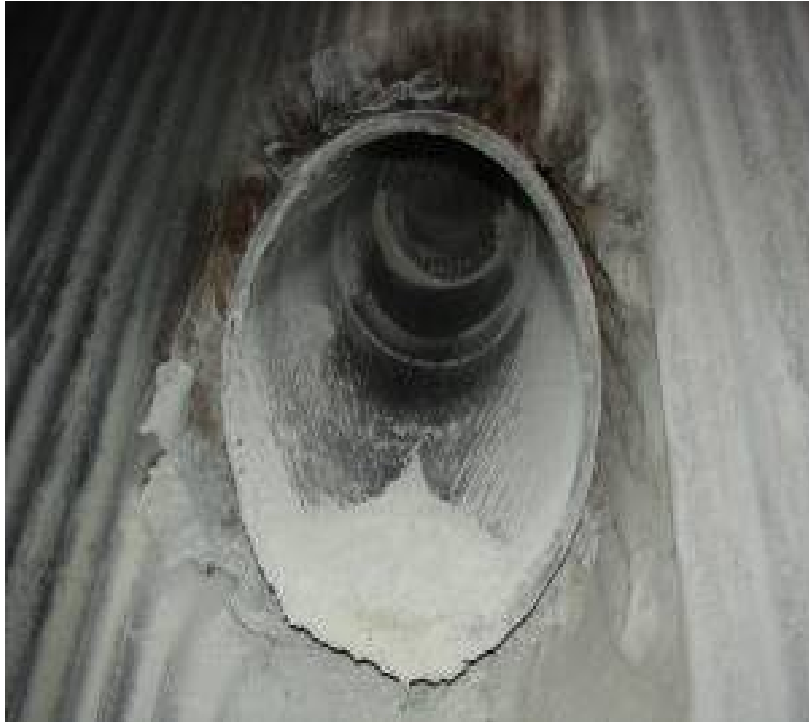
Figura 2. Visão da parte interna da Calha.
