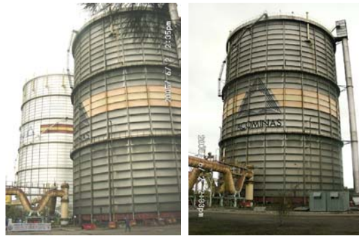
Figura 15. Foto do Gasômetro de Coqueria da Gerdau Açominas.
