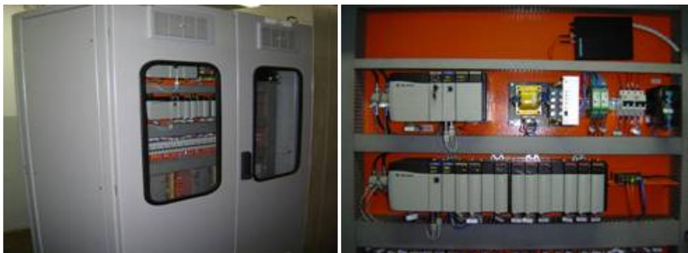
Figura 4. Painel do PLC e vista interna do mesmo (CPU e cartões de I/O)
