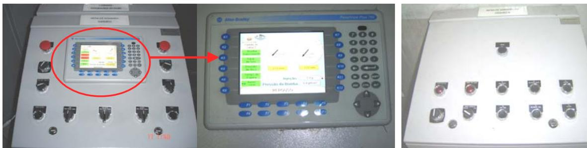
**Figura 7.** Nova mesa de operação (em destaque o PanelView) e mesa de emergência
