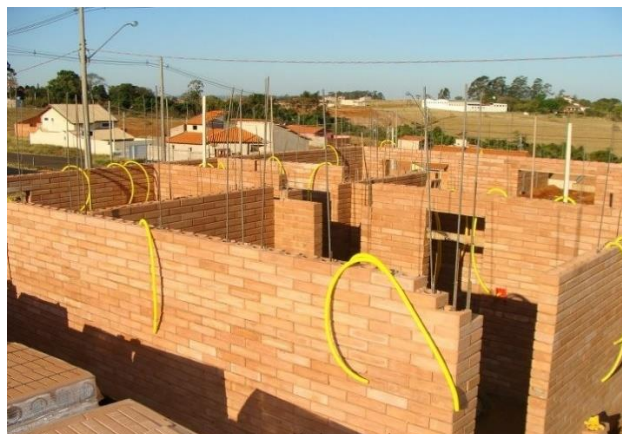
Figura 1. Construção em blocos de encaixe de solo-cimento.
