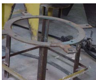
Figura 13 - Suporte para Formas de Concretagem apoiada no próprio piso.
