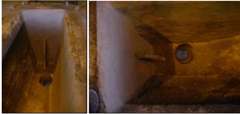
Figura 2. Montaje de la pieza anti vórtice en L1.
