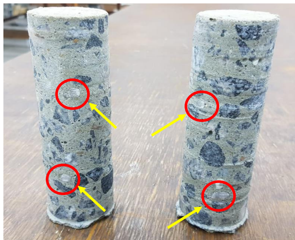
Figura 8. Testemunhos cilíndricos dos furos executados nas vigas estudadas mostrando partes cortadas do aço dos estribos.
