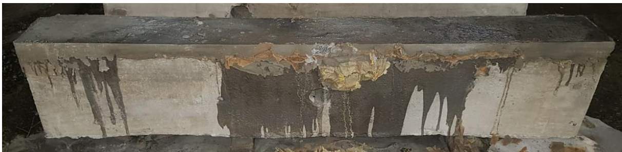
Figura 6. Resultado final do reforço estrutural da viga com vergalhões de aço.
