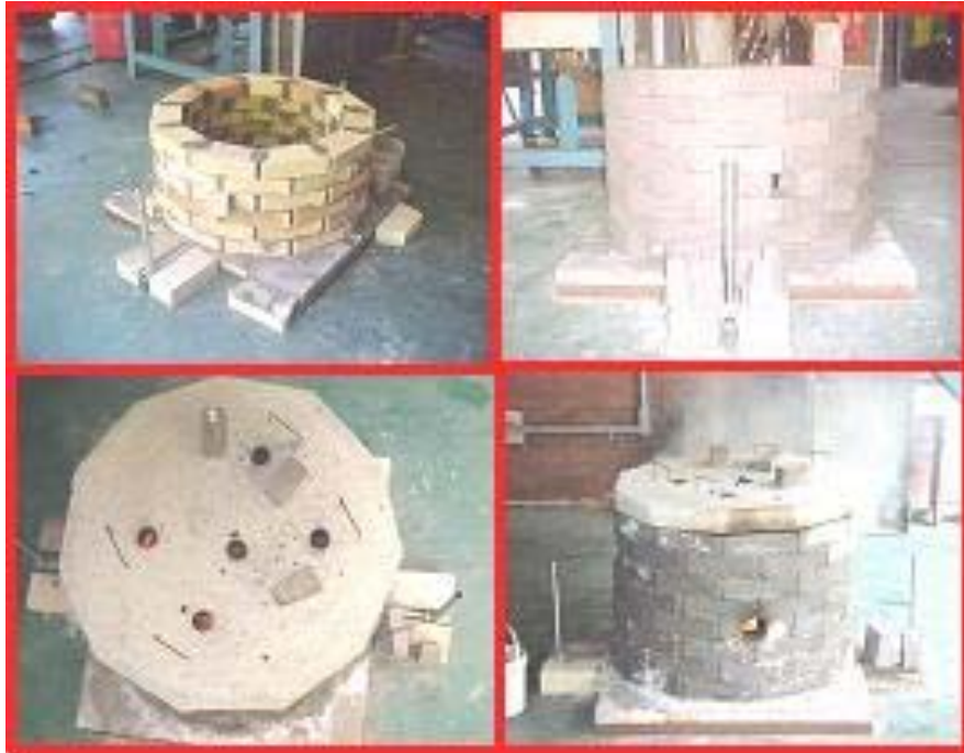
Figura 2 – Forno experimental Alvenaria refratária em construção
