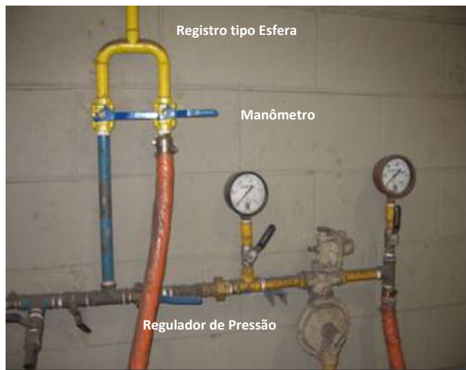
Figura 4. Detalhes das redes de gás e ar, válvulas e reguladora de pressão. (3)
