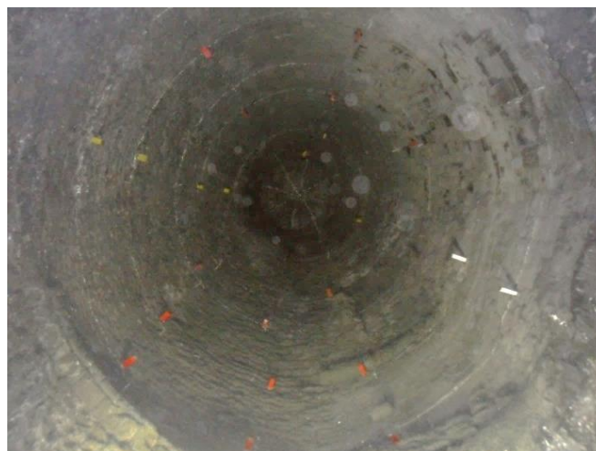
Figura 9. Fotografia da utilização das mestras de tijolo utilizadas como referência.
