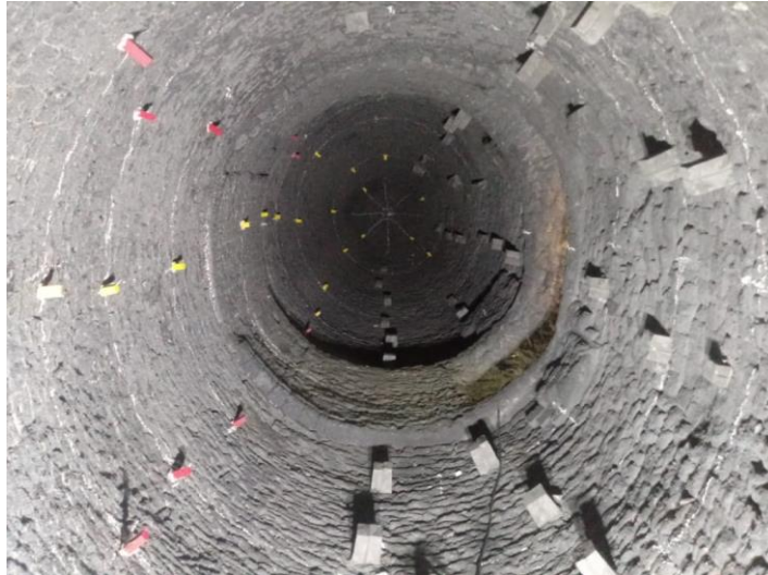
Figura 12. Fotografia do interior do carro torpedo evidenciando as mestras e as ancoragens.
