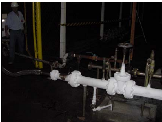
Figura 13 –Alimentação das carretas de recarga (linha congelada) e Limite de bateria CST e WM (válvula esfera);
