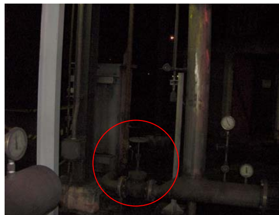
Figura 08 – Ponto de interligação na rede de distribuição de nitrogênio;
