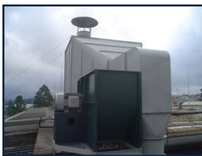
Figura 8 – ECP após modificação.
