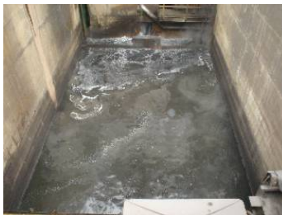
Figura-2: Condicionamento do Poço de Carepas antes das melhorias
