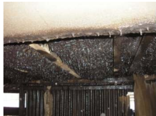
Figuras 5 e 6: Condicionamento da tubulação de água de alimentação e recheio da torre
