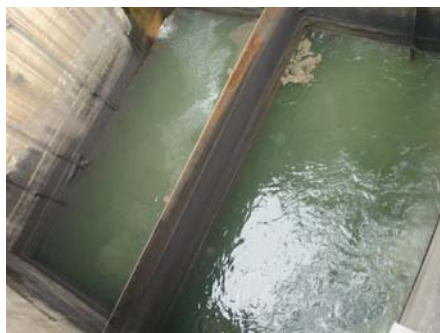
Figuras 11 : Poço de carepas
