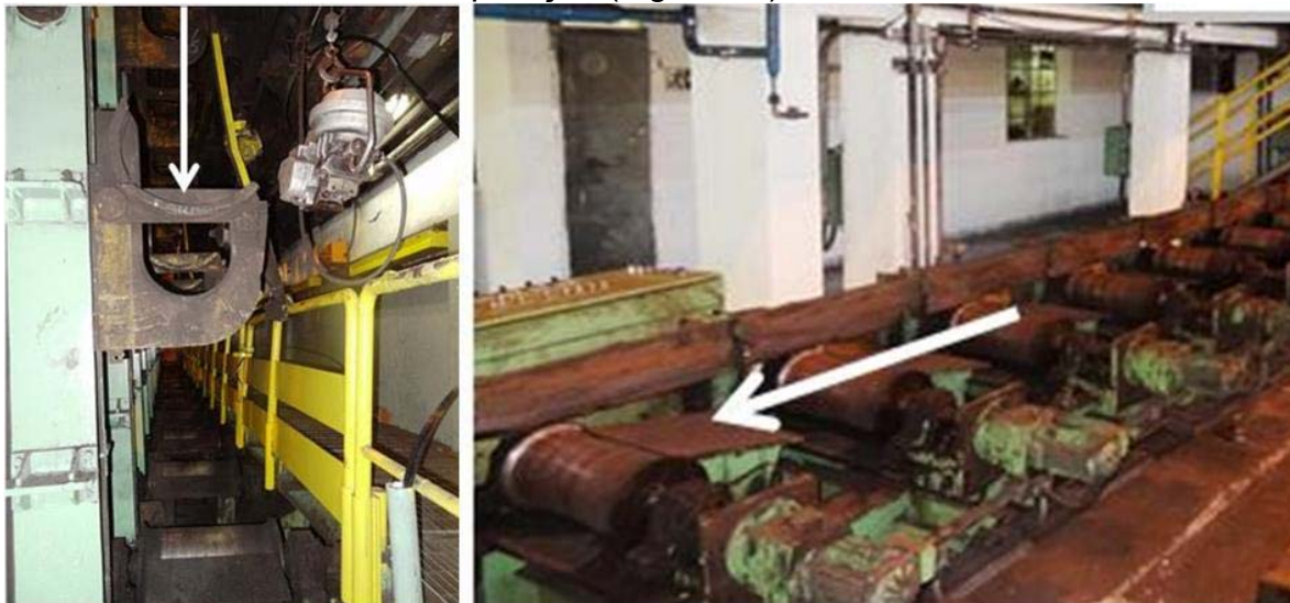
Figura 12 – Mesas de rolos que foram substituídas
