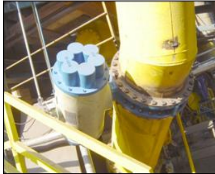
Figura 11. Novas válvulas de bloqueio
