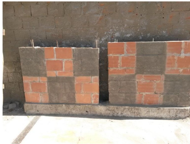
Figura 1 – Parede de tijolos construída para o teste de aderência.
