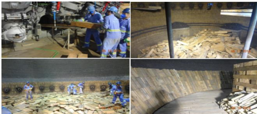
Figura 9. Imagem do procedimento de enchimento do cadinho com madeira
