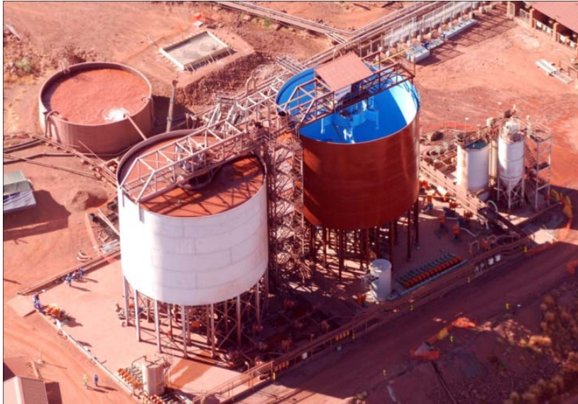
Figura 7. Espessadores secundários de pasta, localizados na região da barragem.
