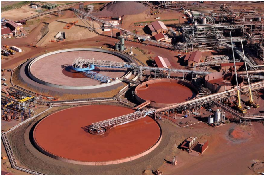
Figura 5. Dois espessadores de tração periférica de 90 m de diâmetro e tanque simples de coleta de overflow.
