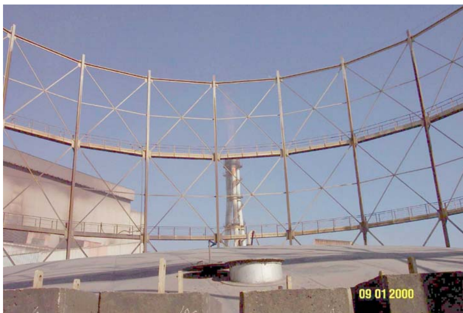
Figura 1 – Estrutura externa gasômetro da Aciaria
