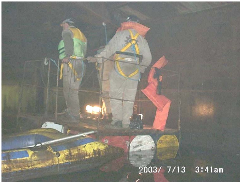
Figura 14. Balsa flutuante utilizada para execução dos serviços.
