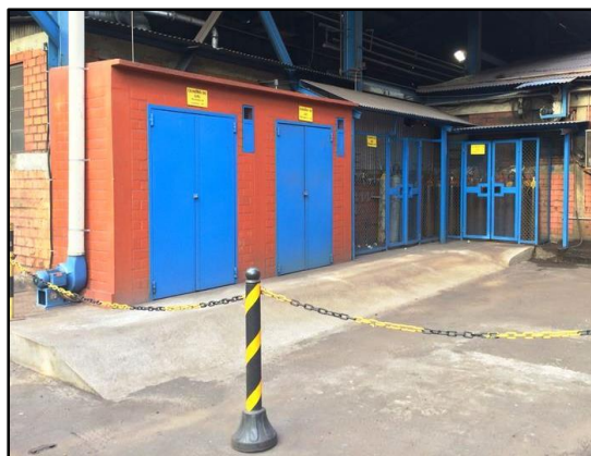
Figura 7- Apanha dos gases (CO e XX enclausurados e com sistema de exatão)
