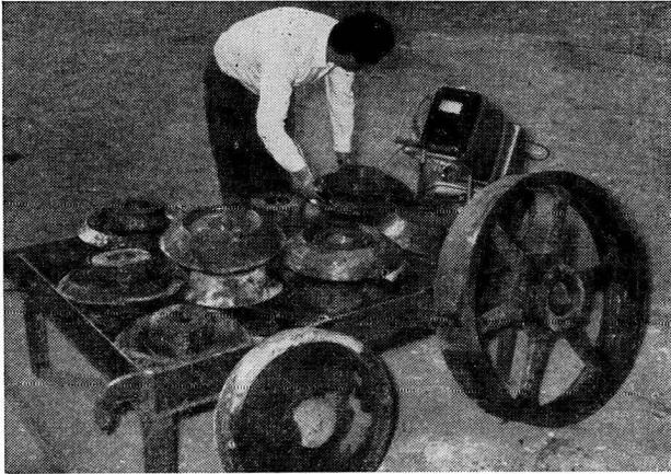
Fig. 20 — Exame de diversos tipos de engrenagens, antes da usinagem e tratamento térmico.
