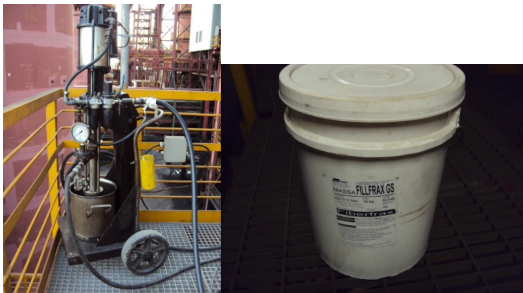
Figura 11. Máquina para injeção de massa refratária e o balde com a especificação da massa
