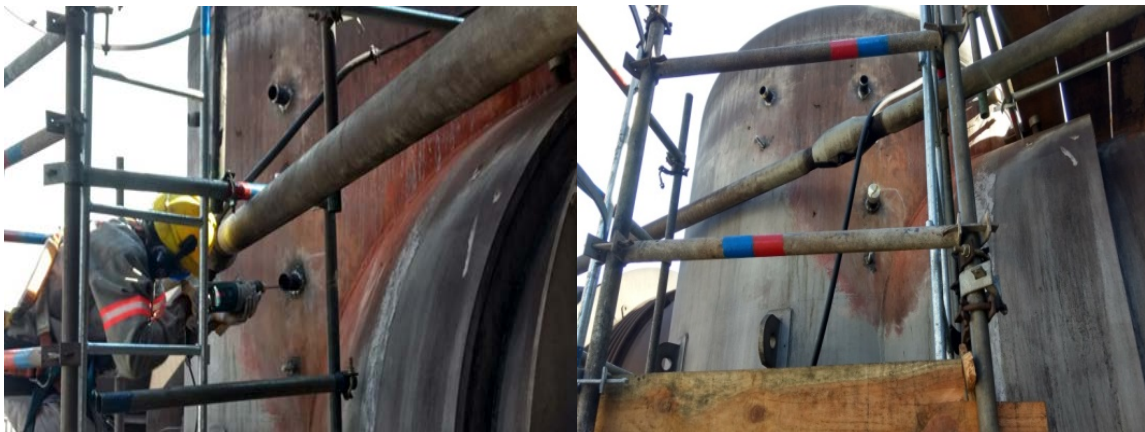
Figura 9. Limpeza aonde já existia o Nipe e colocação de tampão a ser usado após a injeção
