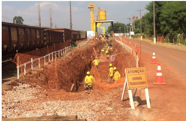
Figura 06. Obra em fase inicial.
