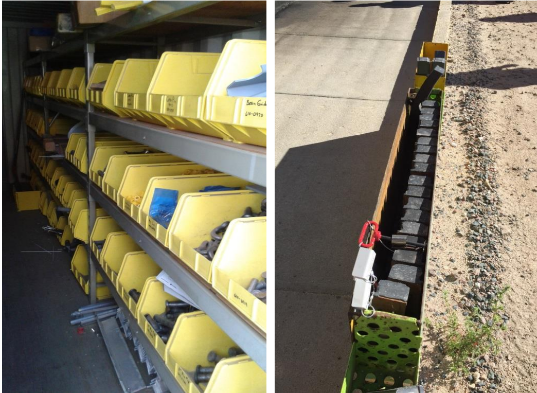
Figura 02. Materiais dentro do container e dispostos ao longo da vala da BNSF.
