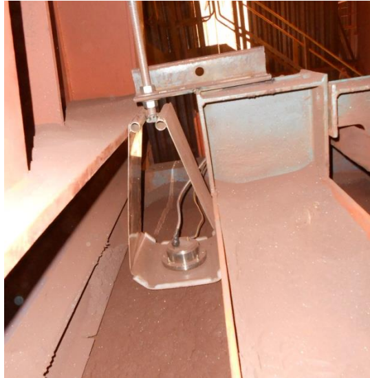
Figura 3 - Instalação do sensor para medição de umidade.
