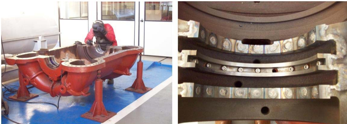
Figura 8. Detalho do reparo da carcaça.
