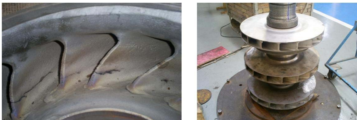
Figura 9. Reparo do booster IHI-1.
