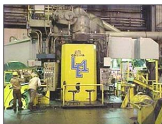
Figura 2. Laminador de encruamento n.º1.
